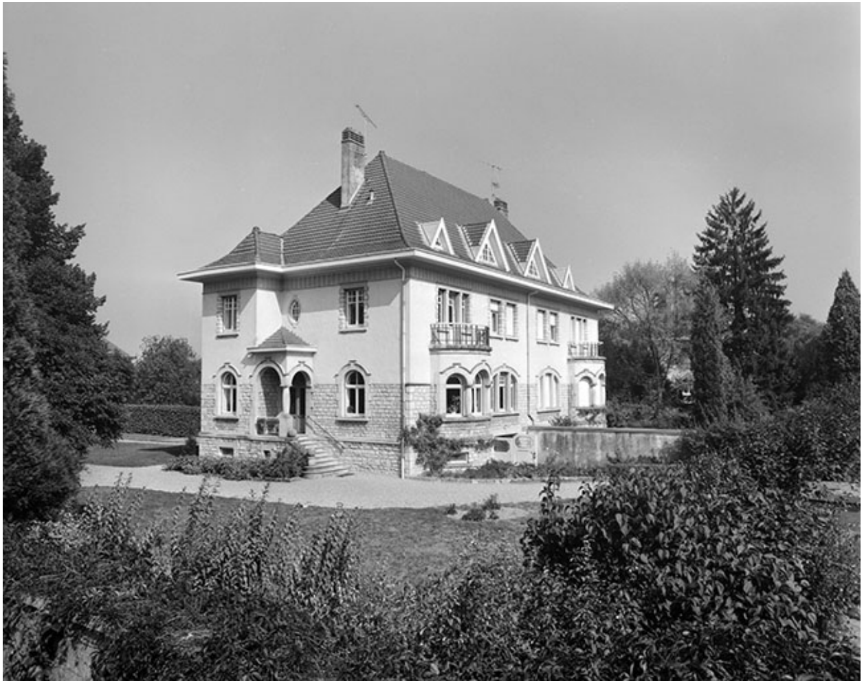
Vue générale de la maison 1, 3 avenue Ernest Solvay.
