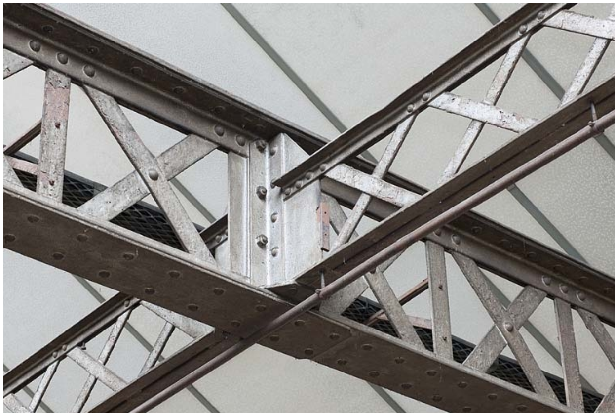
Intersection de poutrelles à treillis.
