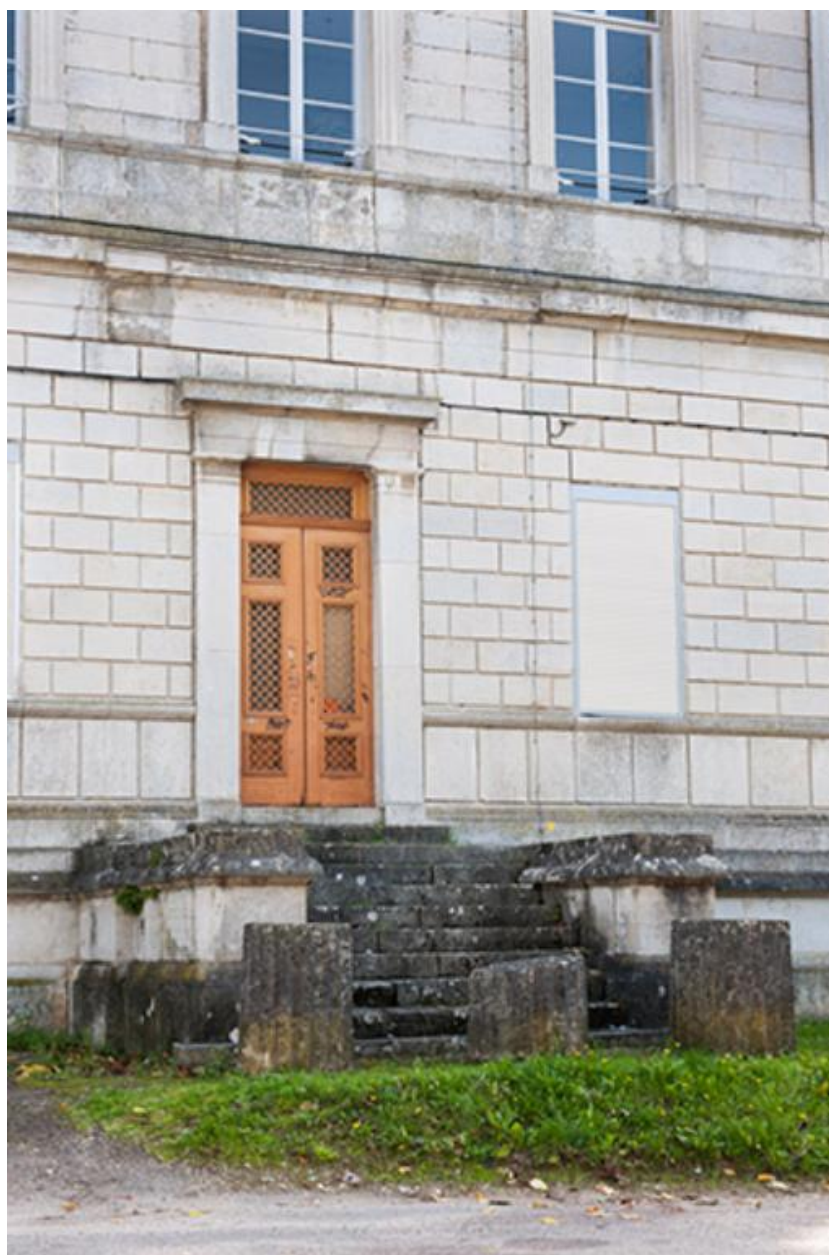
Porte de la façade nord
