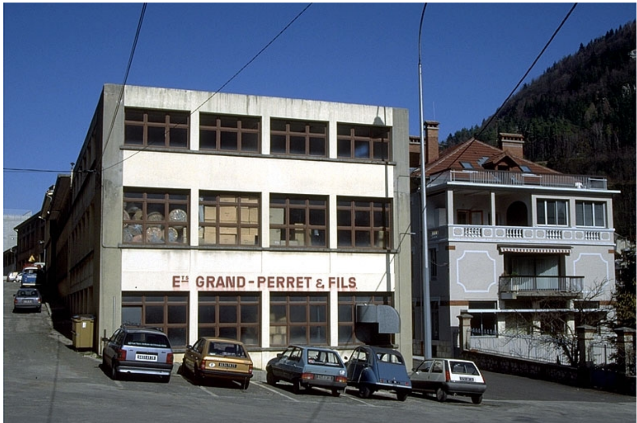
Atelier de fabrication et bureau.
