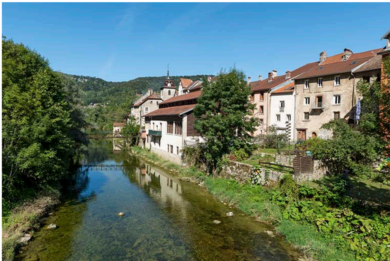
Vue d'ensemble, depuis le pont au sud.
