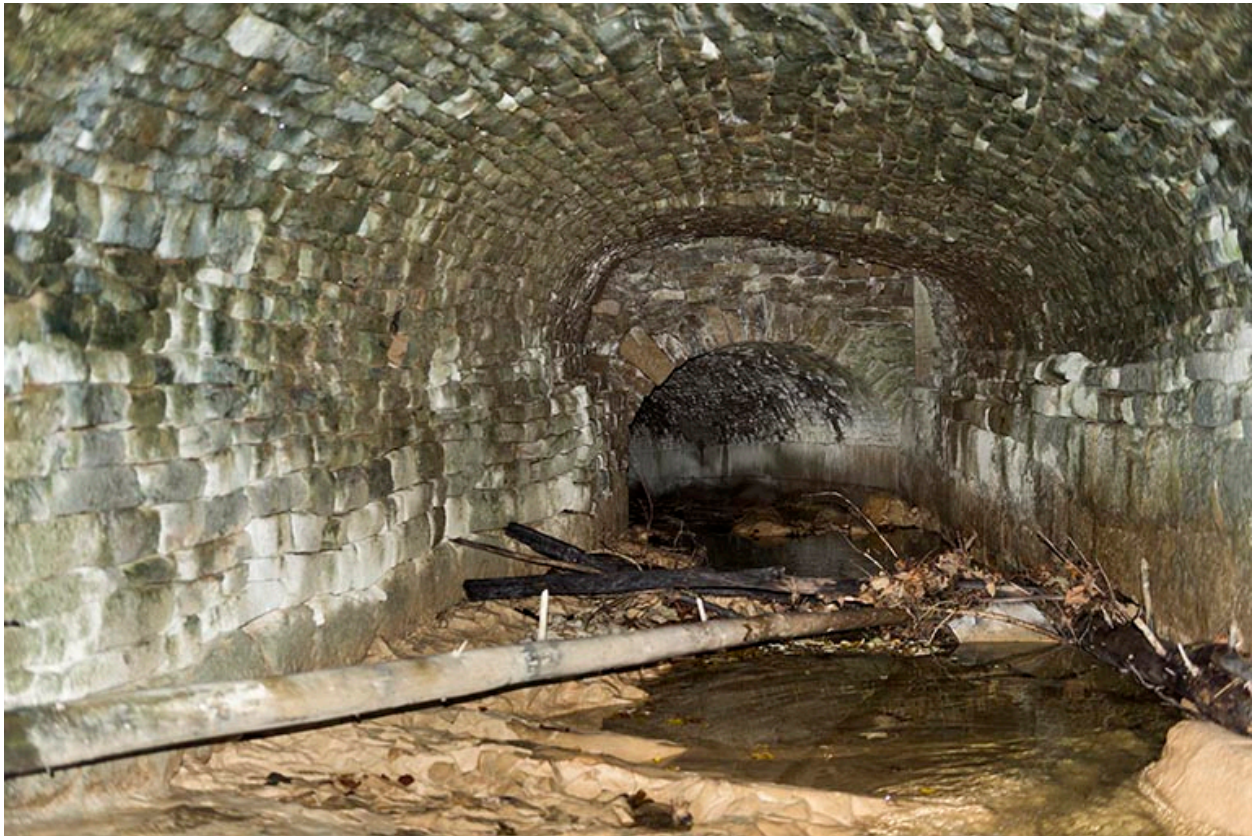
Voûte sur le ruisseau couvert.
