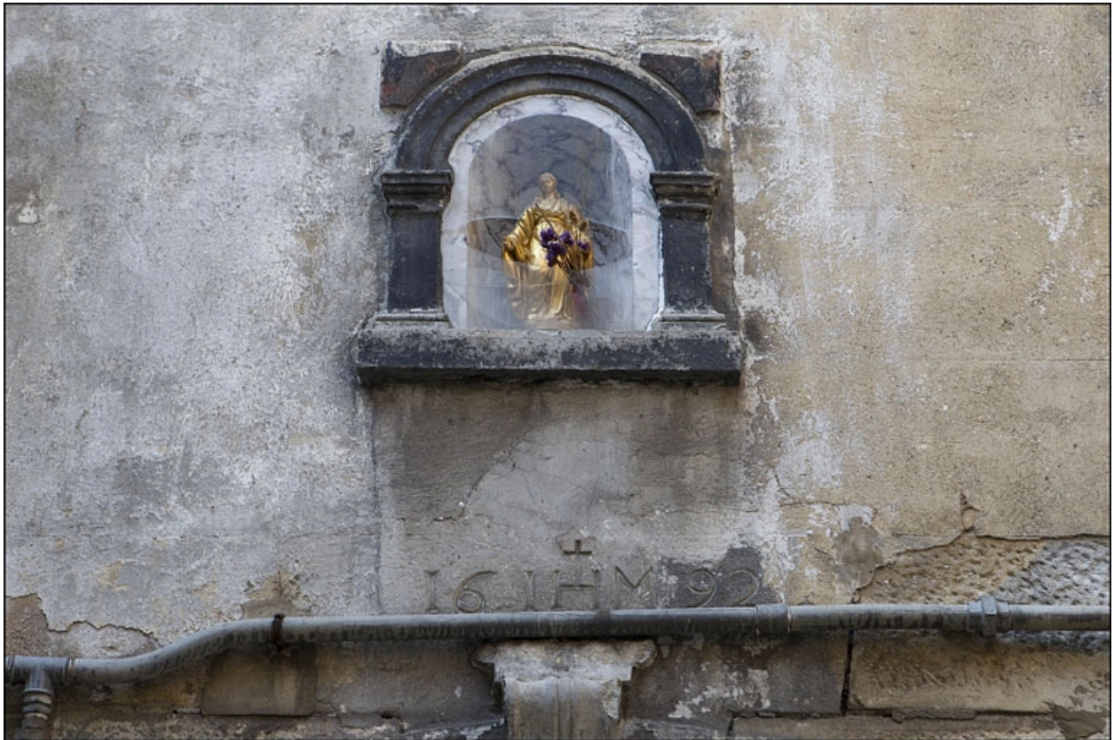
Détail de la niche sur la façade antérieure du premier logis secondaire.
