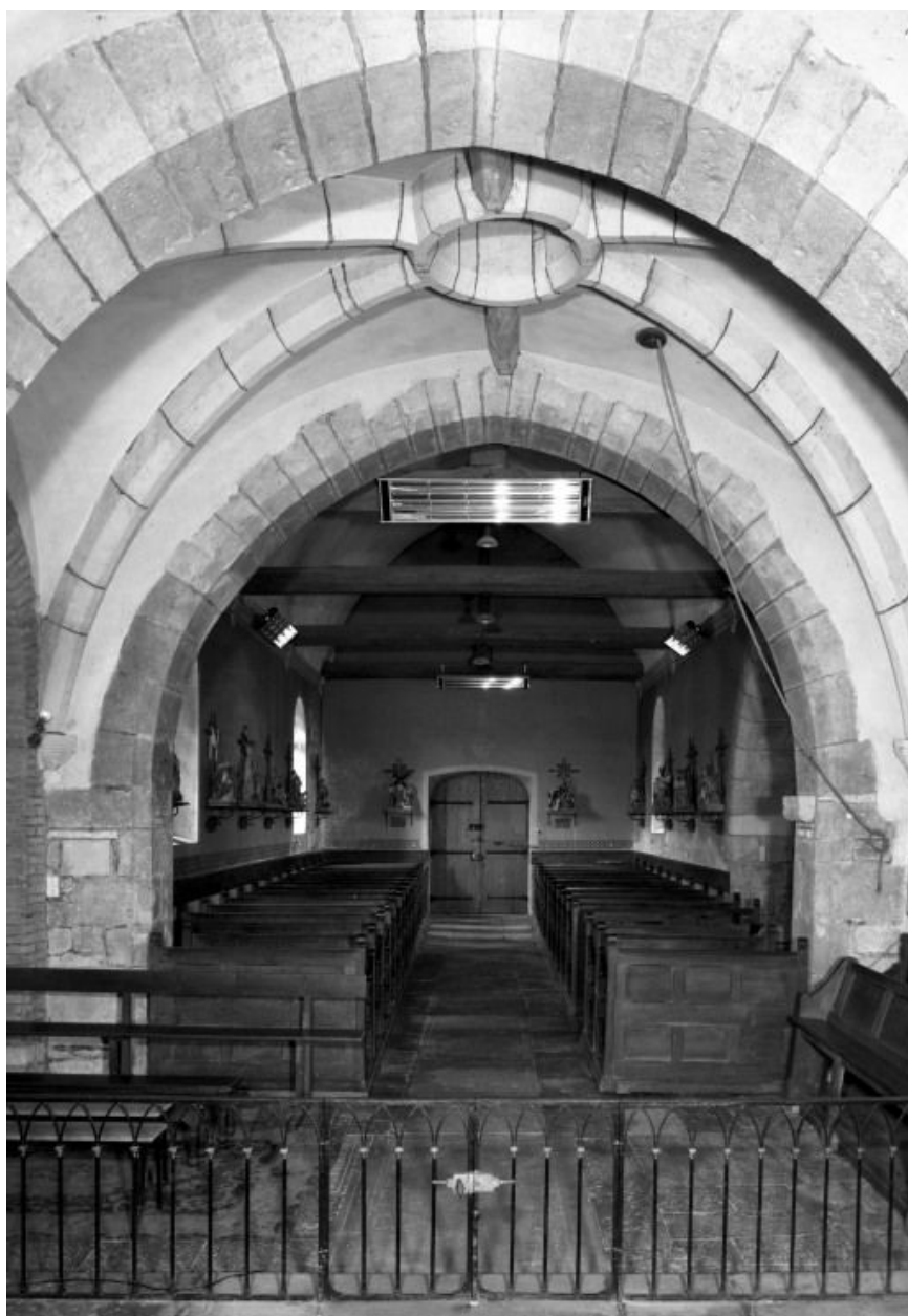
Vue intérieure prise du chœur
