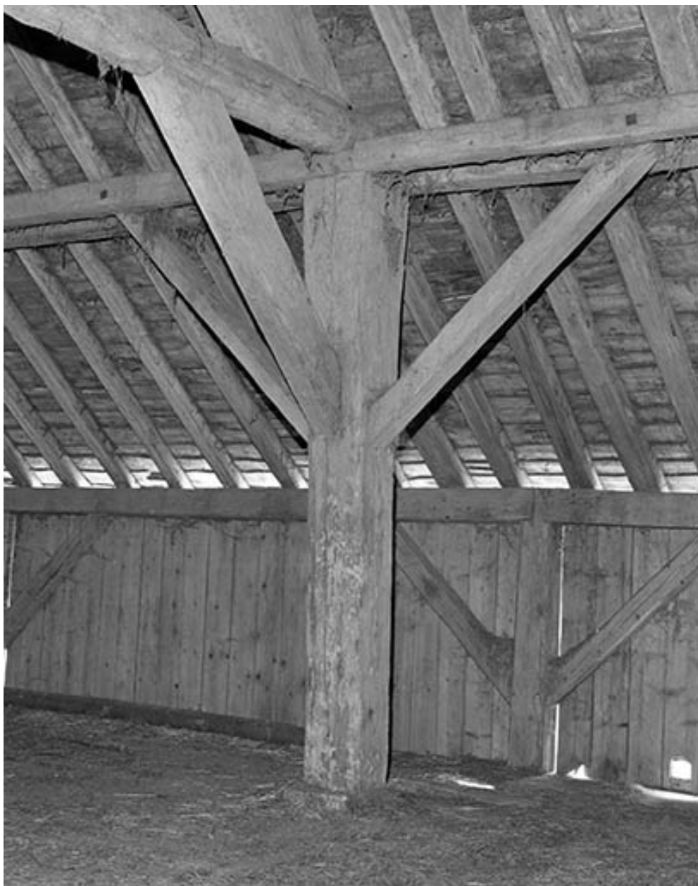
Charpente, partie inférieure au niveau d'une ferme.
