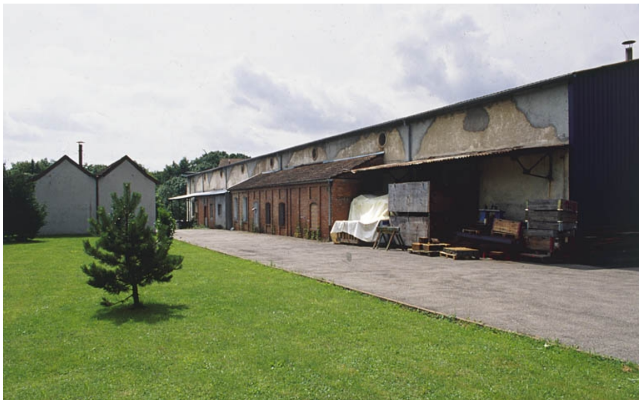
Façade postérieure des ateliers de fabrication.
