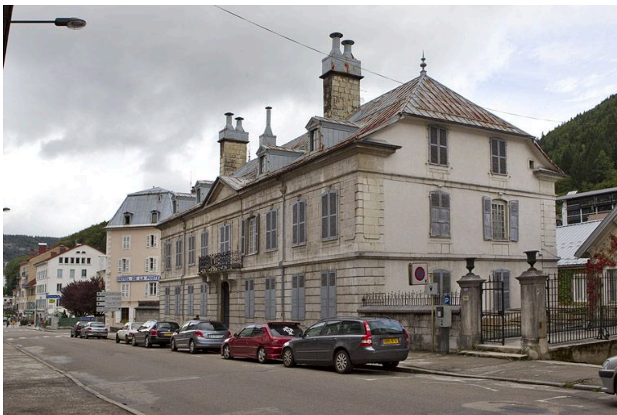
Façade du logement patronal, sur la rue.
