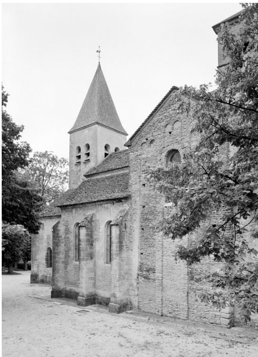
Elévation droite et clocher antérieur
