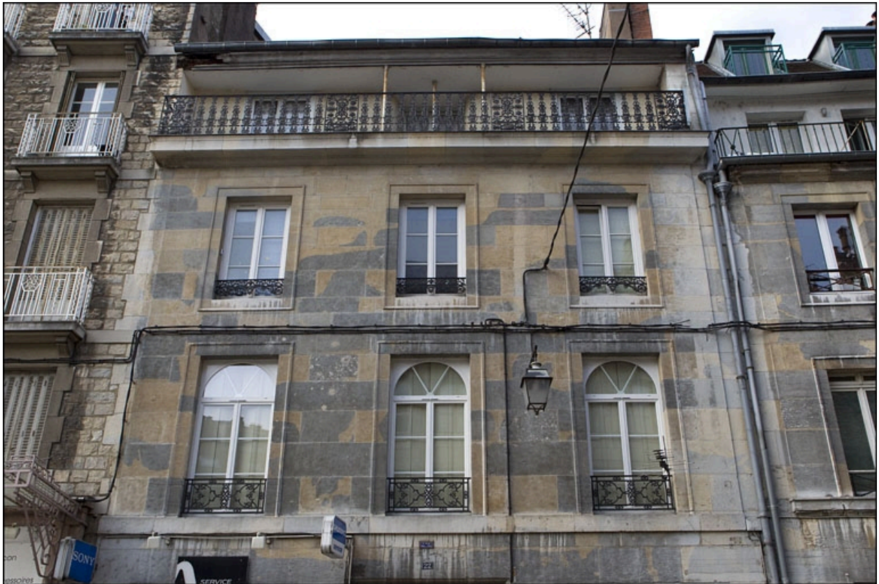
Vue de la façade antérieure sur rue du logis principal à partir du premier étage.
