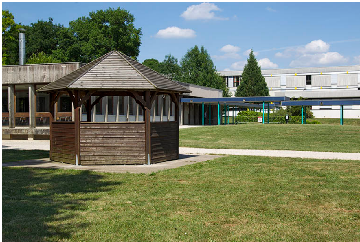
Kiosque à l'angle sud-ouest de la cantine.
