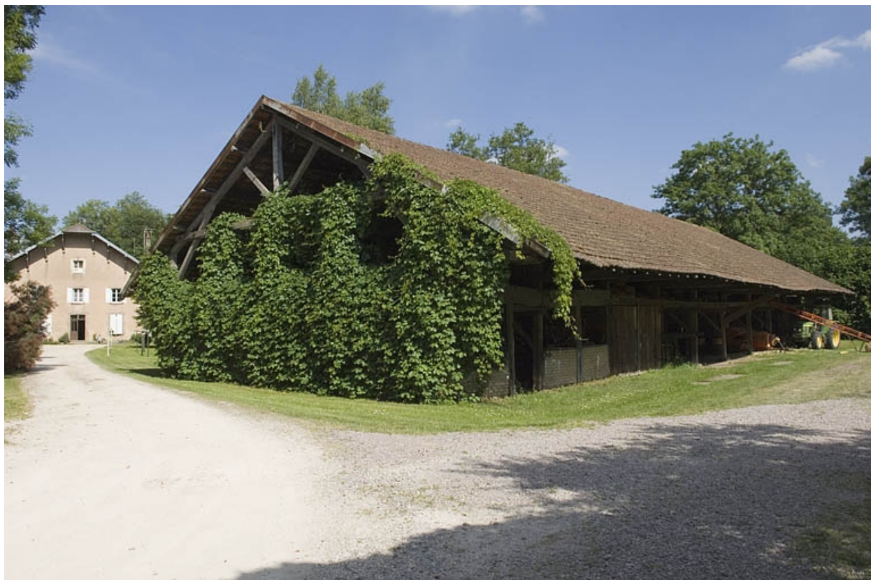
Entrepôt industriel vu depuis l'ouest.
