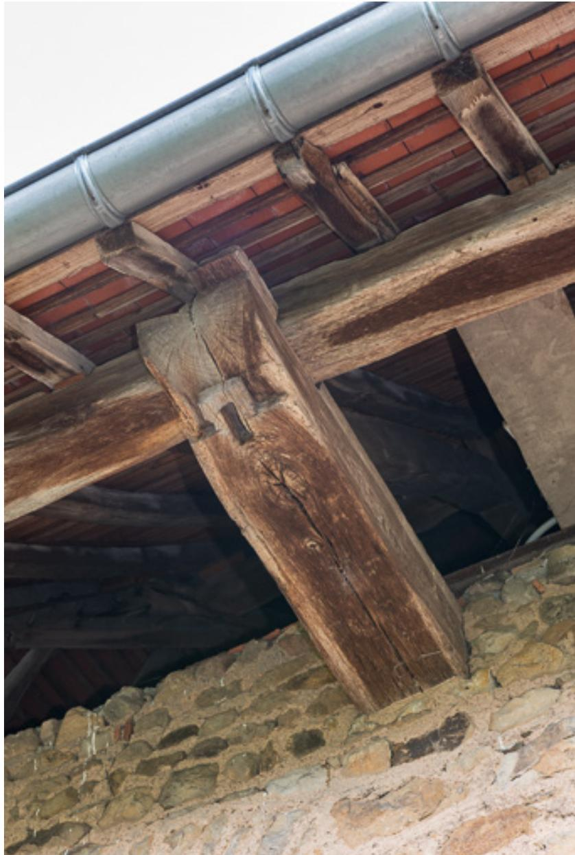
Cette solive, sur laquelle repose le plancher des combles de la maison, forme encorbellement et soutien le débord du toit. Le trou (ou mortaise) indique qu'un pilier en bois venait s'assembler avec la solive. Ce pilier était un élément de la galerie qui se développait à l'origine au premier étage de la façade de la maison.
