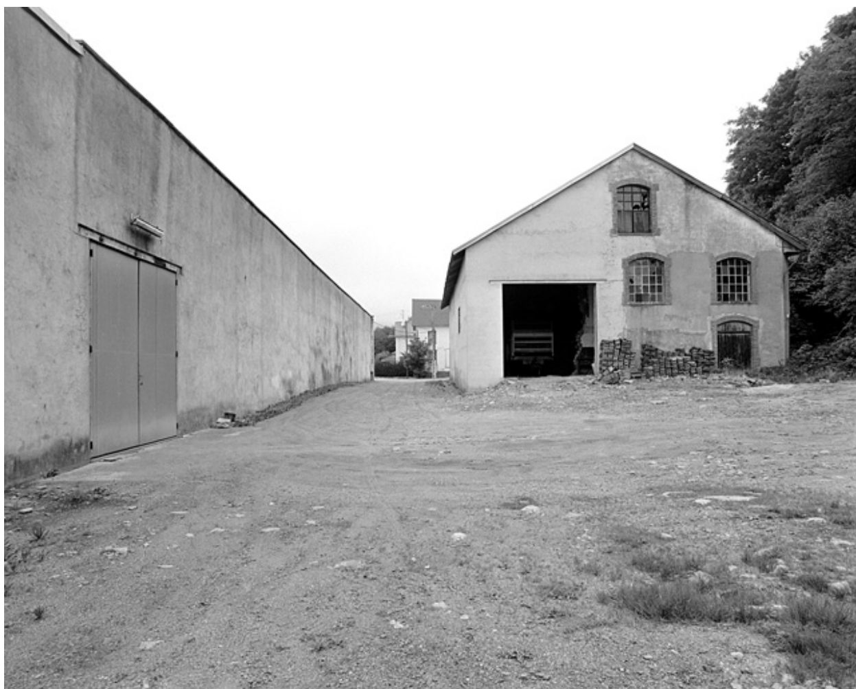
Façade postérieure de la salle des machines.
