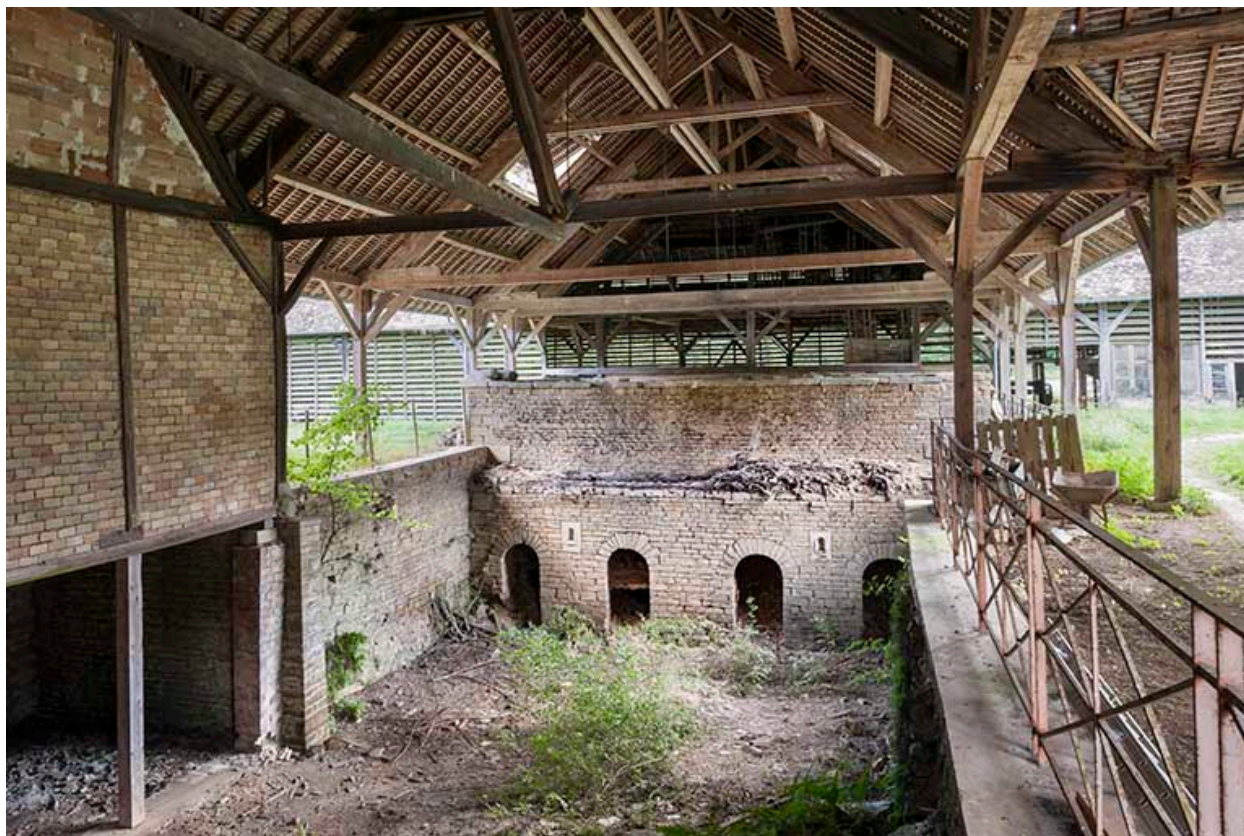
Tuilerie des Combes de Punay, à Malbrans : aire d'enfournement et gueules de charge des fours.
