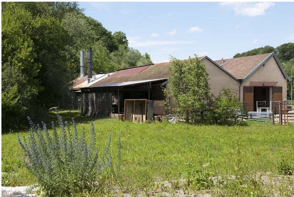
Magasin général. Vue de trois quarts arrière.
