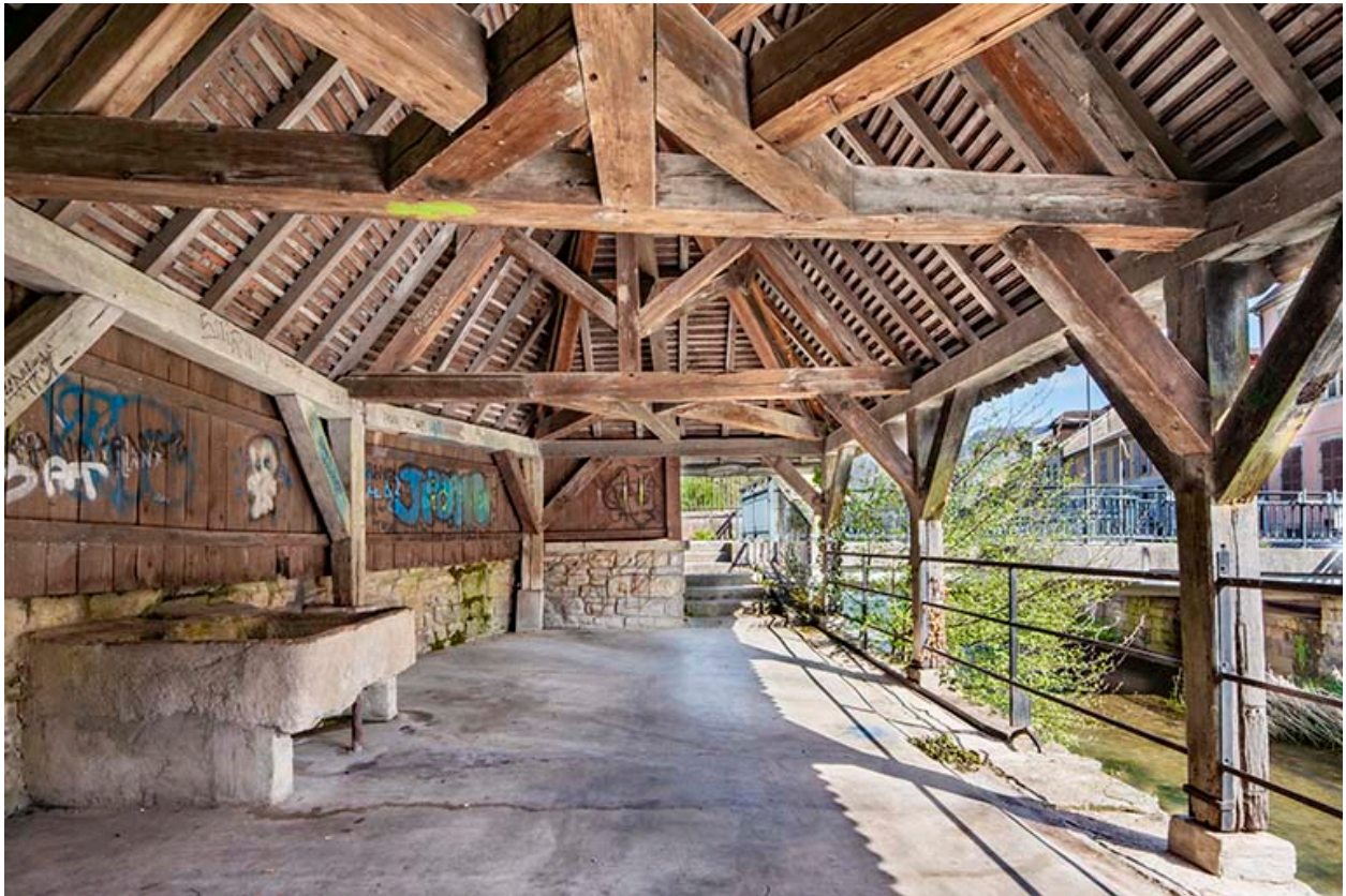
Vue de la charpente, depuis le sud.
