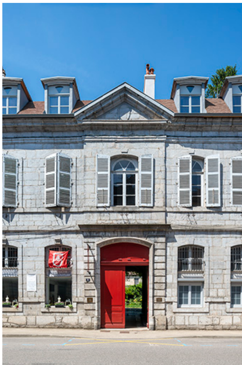
Façade antérieure. Travées centrales.
