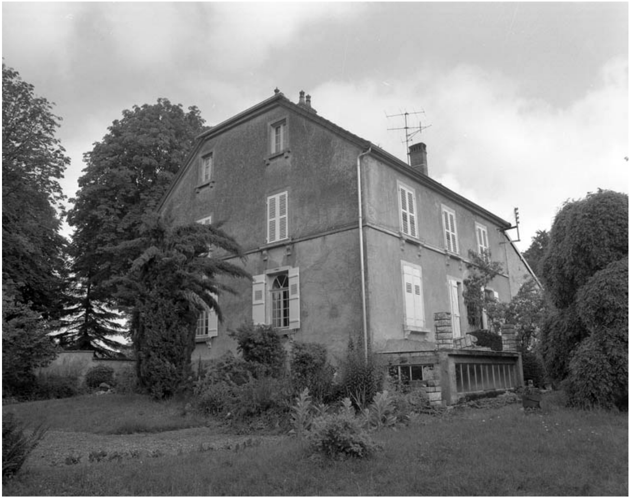
Façades postérieures et latérales droite.
