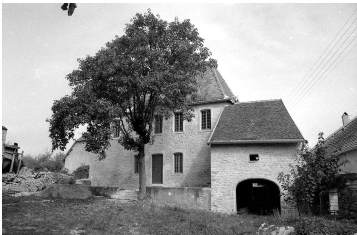
Vue d'ensemble, éloignée, de la maison d'habitation.
