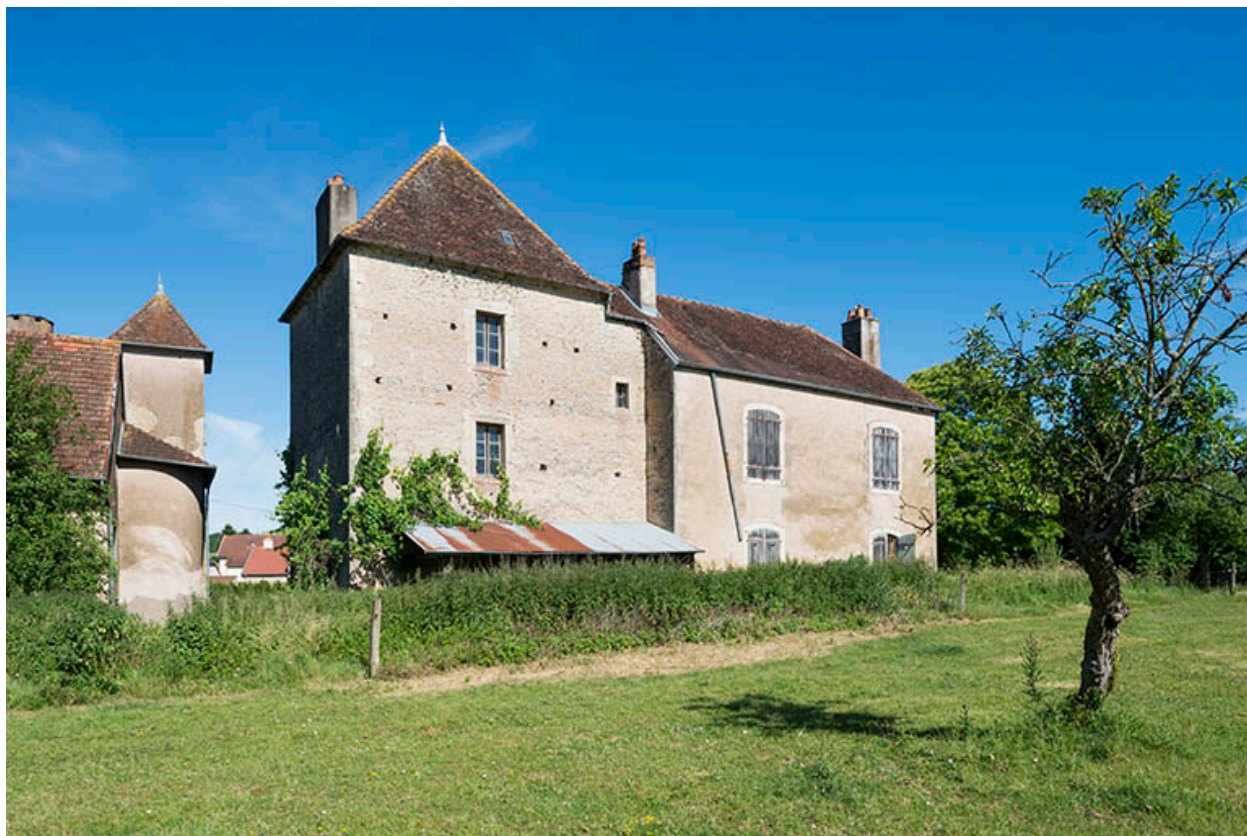
La façade postérieure du bâtiment XVIIIe.
