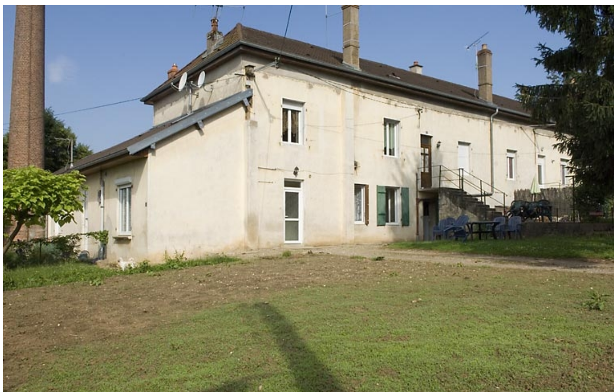
Cheminée, salle des machines et ancien atelier.
