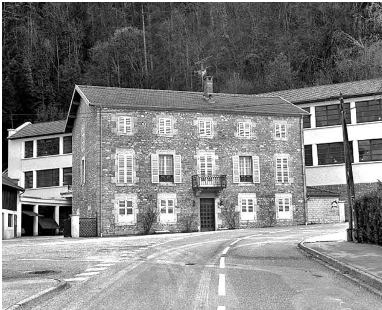
Façade antérieure du logement patronal.
