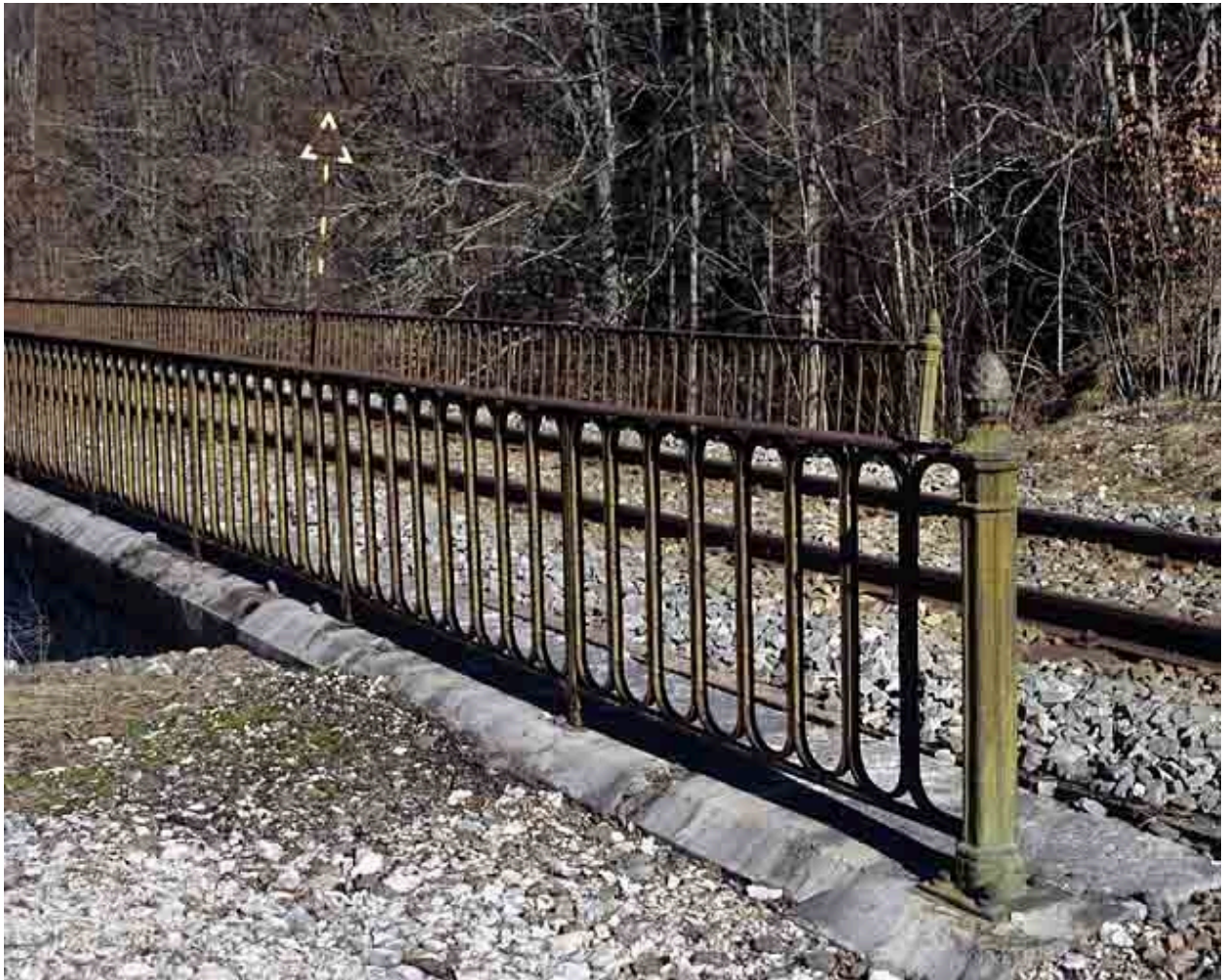
Extrémité du garde-corps métallique.
