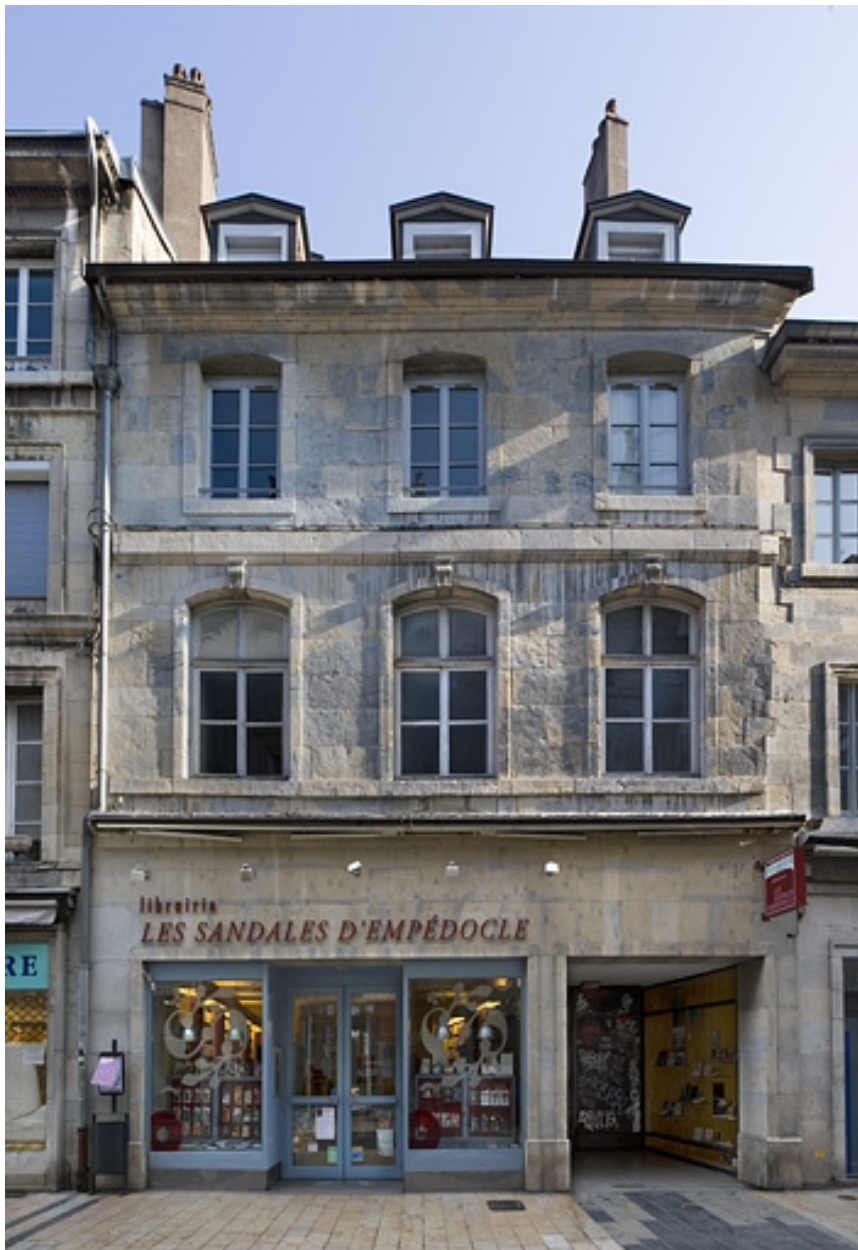
Façade sur rue : de face.
