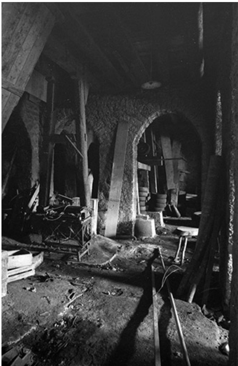
Etage de soubassement des ateliers de fabrication.
