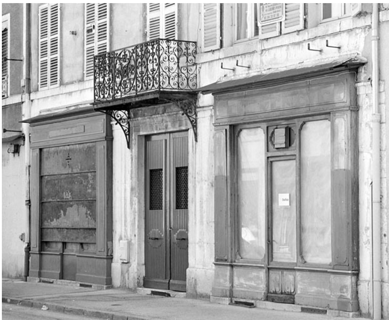
Boutiques au rez-de-chaussée.
