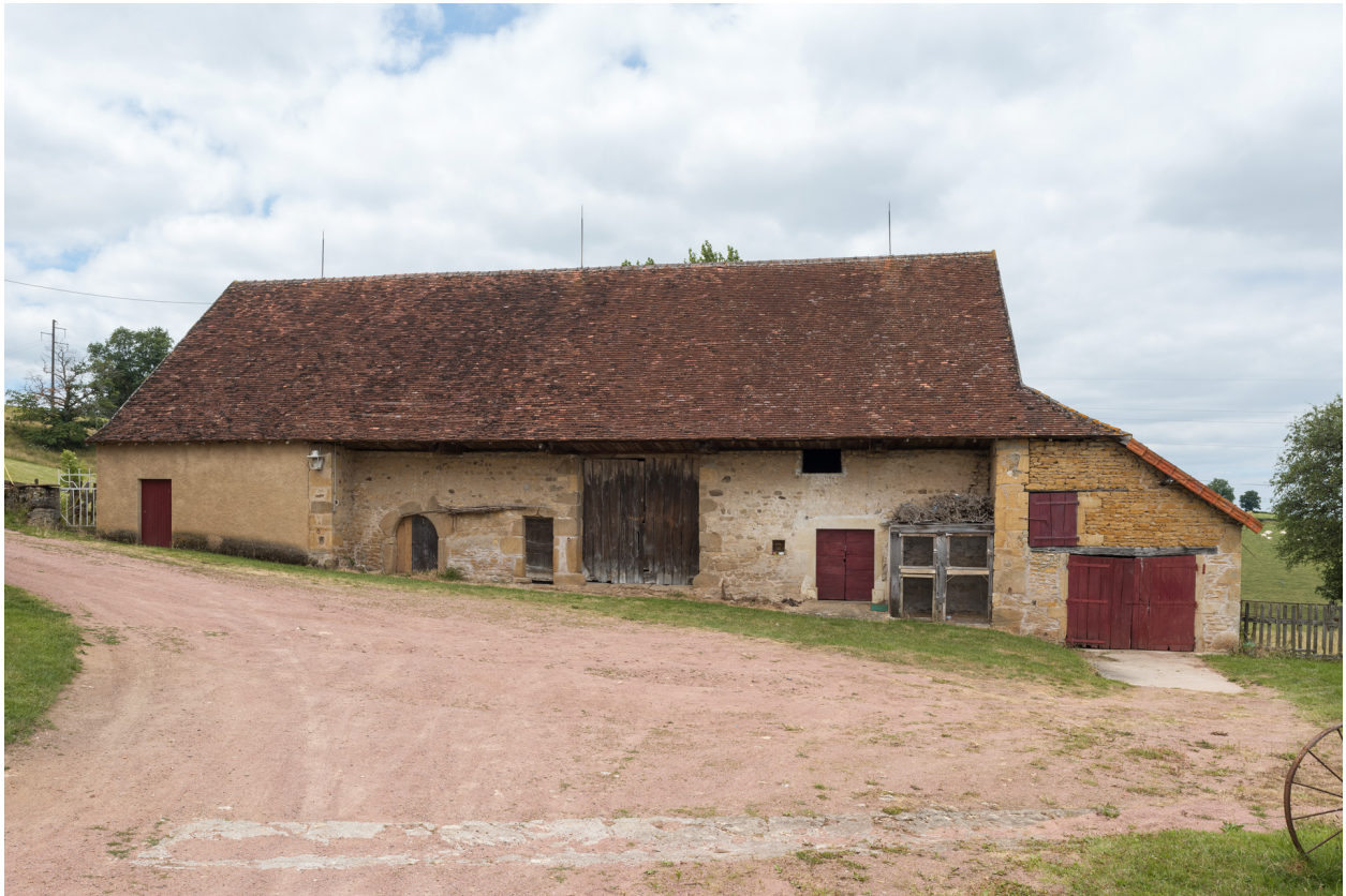
Façade antérieure du bâtiment agricole (étable, remise, fenil).
