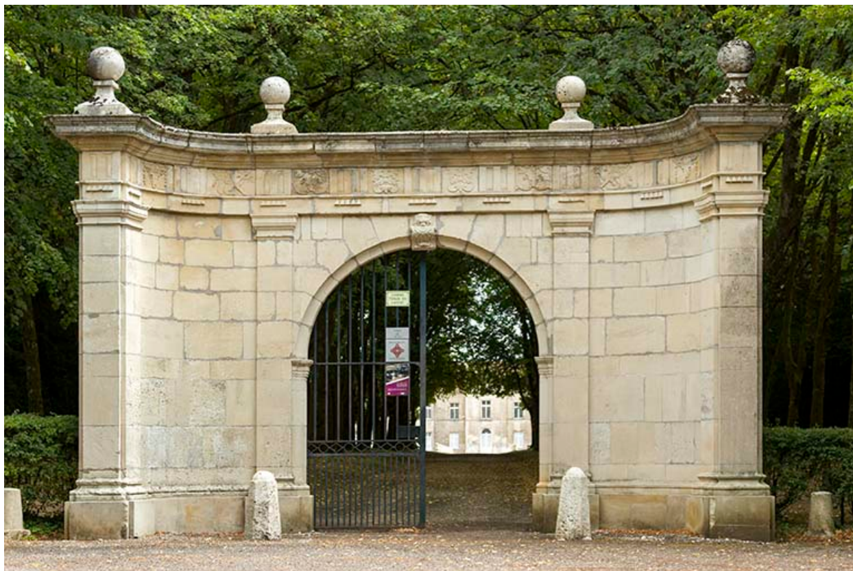
Portail à l'entrée du parc.
