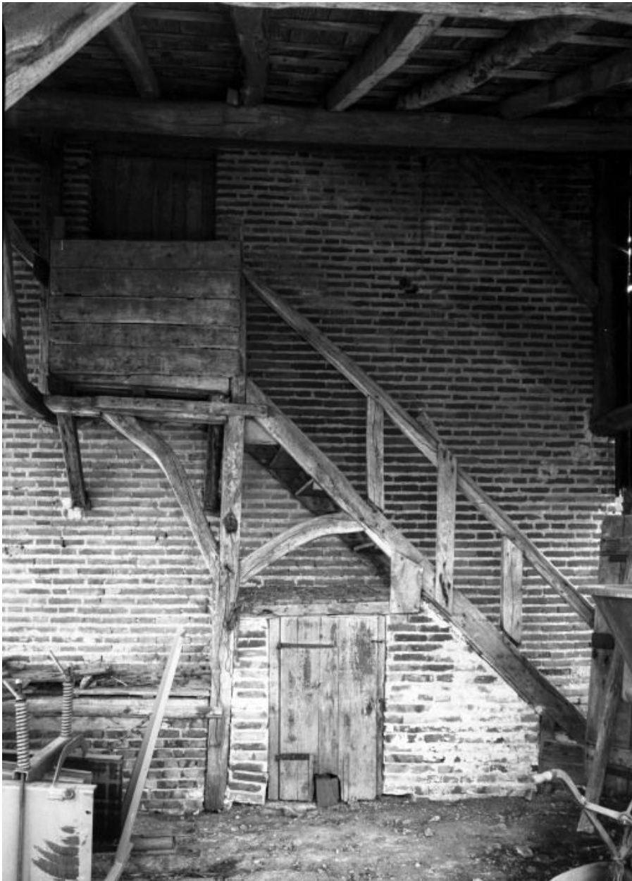
Détail : escalier en bois.
