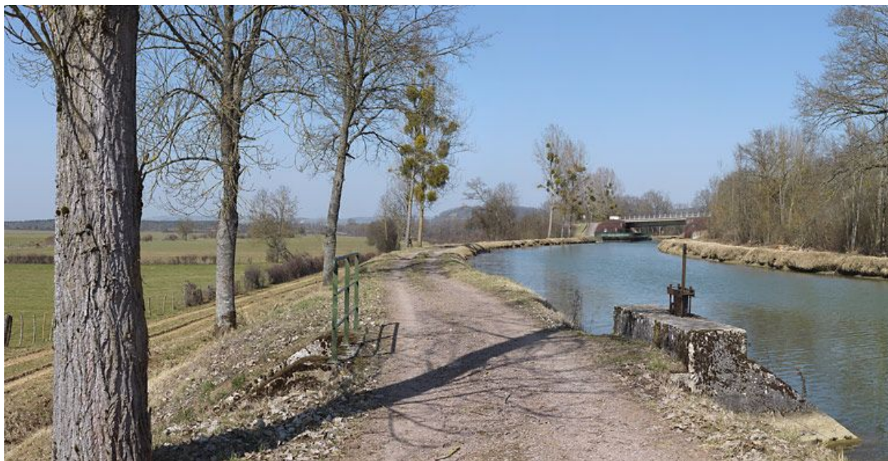
Le déversoir rive gauche dans son environnement.
