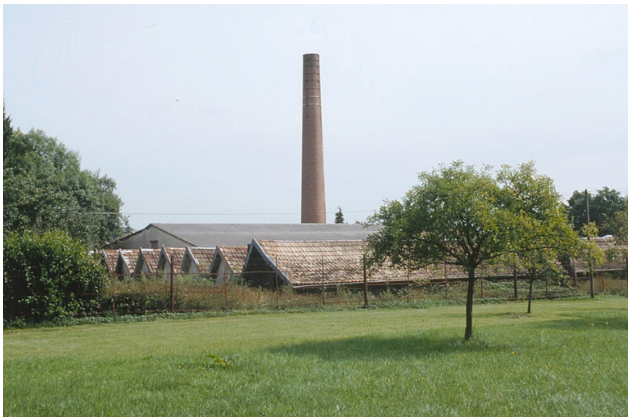
Ateliers de fabrication depuis le sud-ouest.
