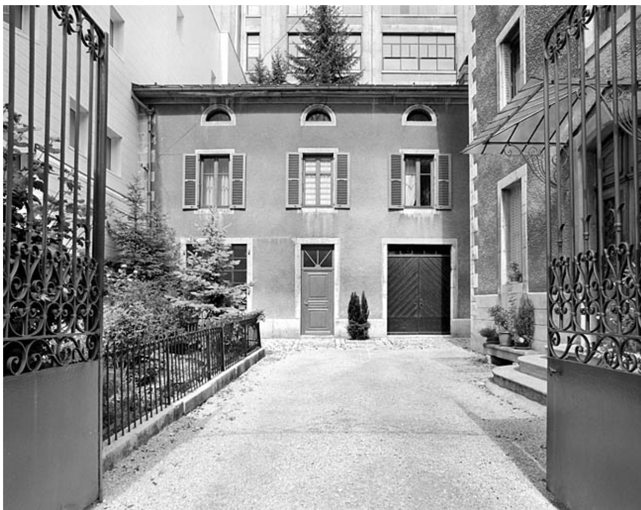
Façade antérieure de l'atelier.
