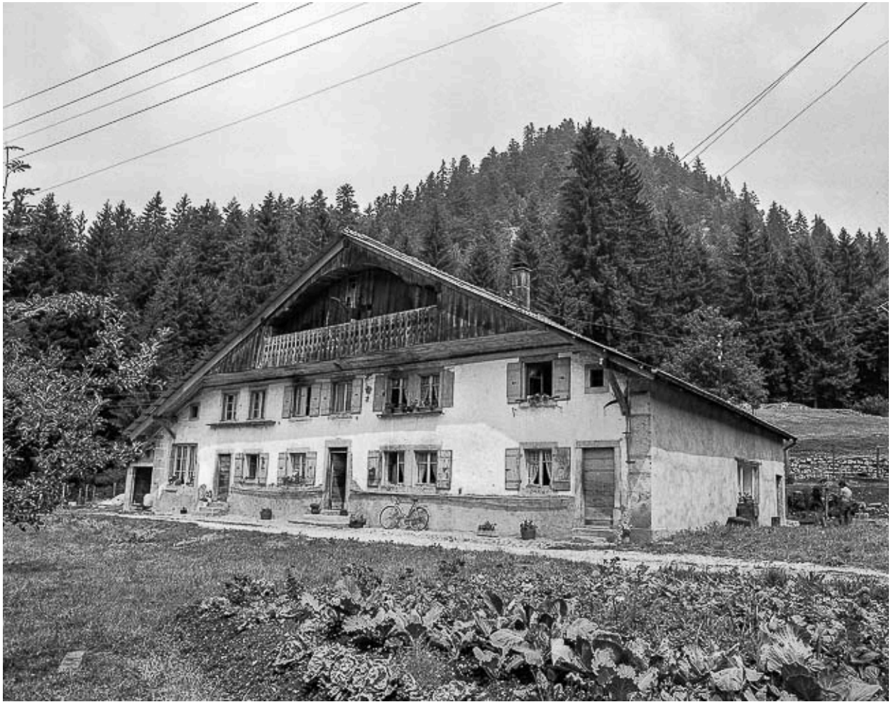
Ferme située au lieu-dit Le Dessus de la Fin, cadastrée B 1-6 : façades antérieure et latérale droite.
