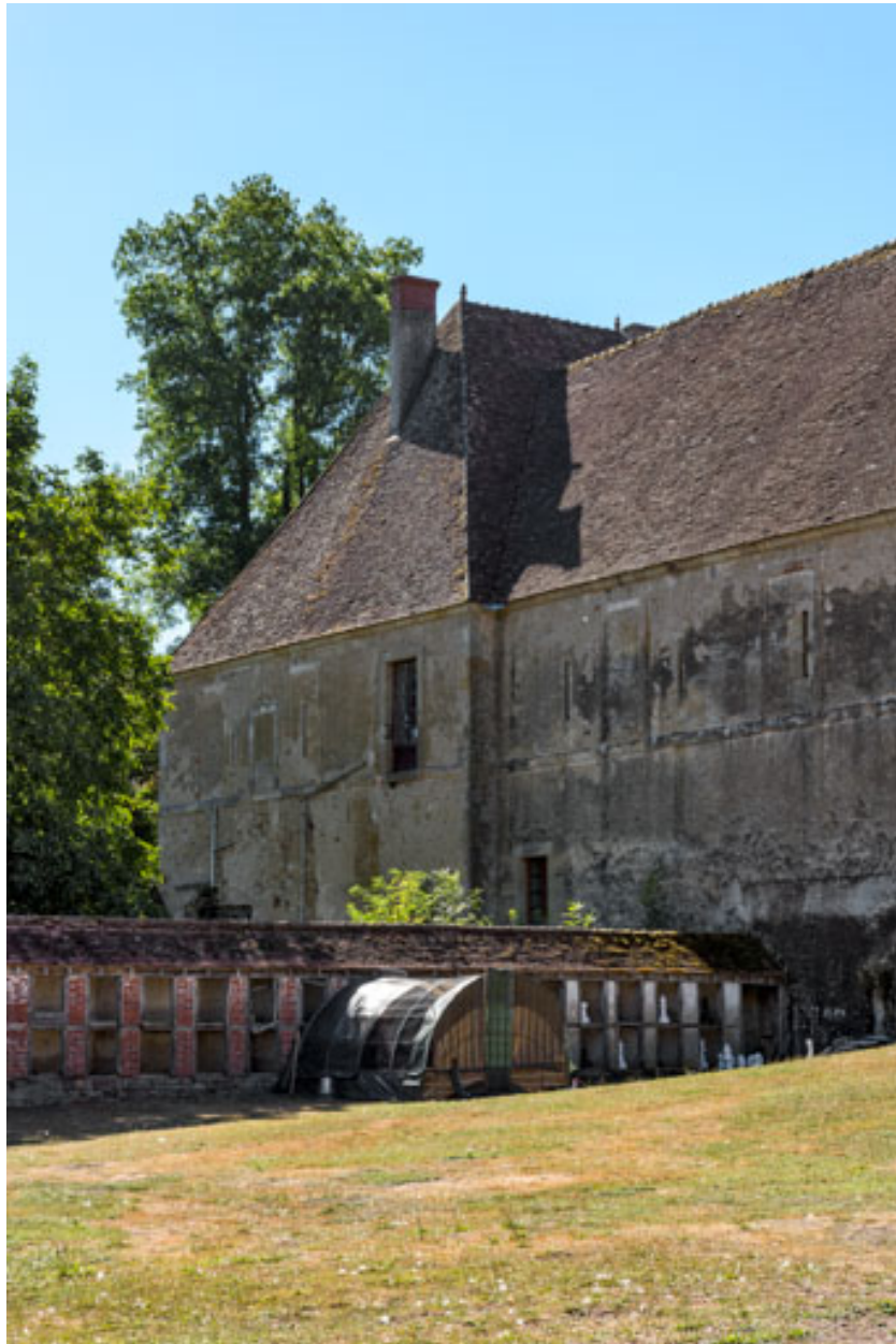
Façade postérieure : pavillon oriental.
