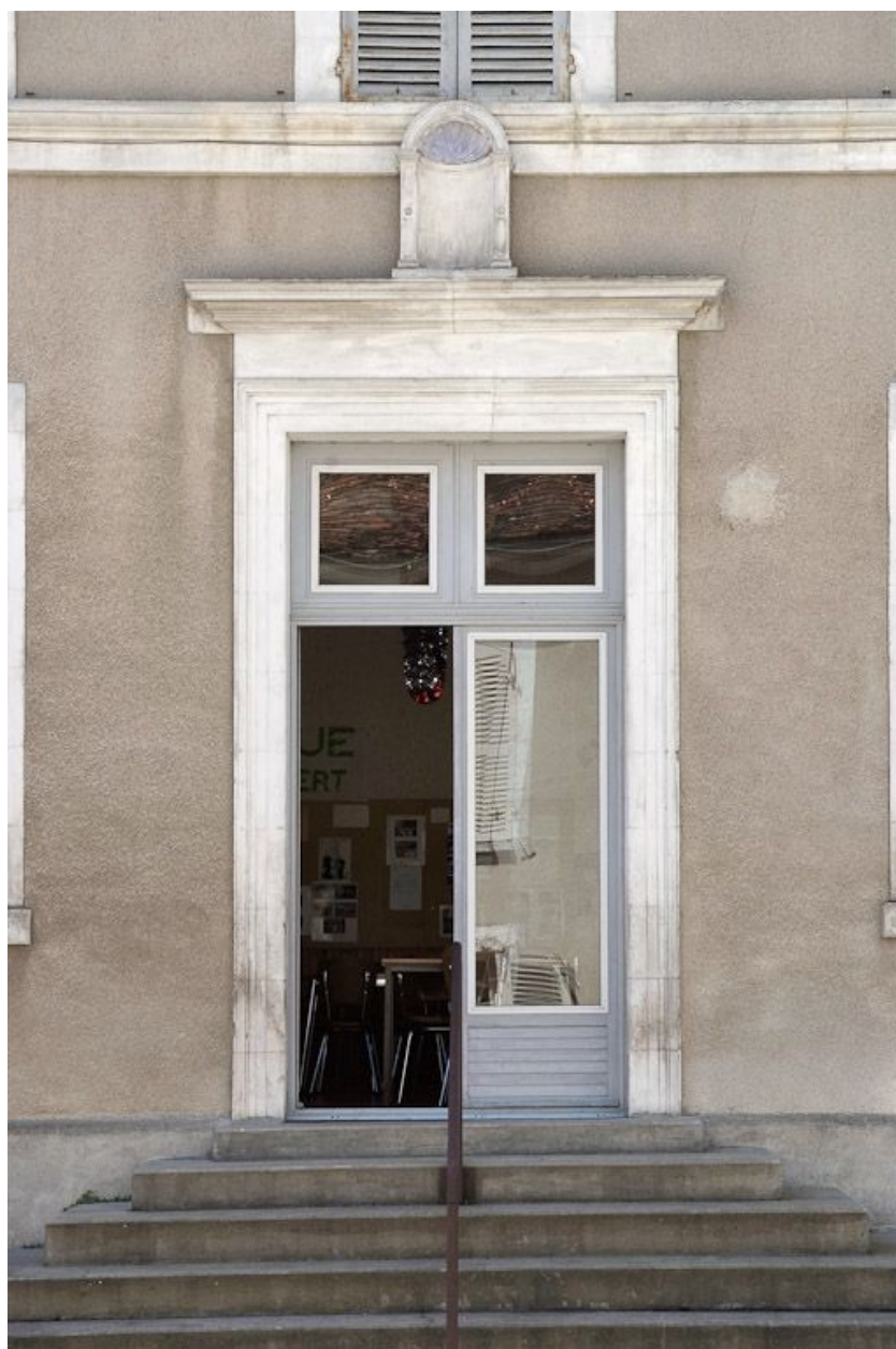
Bâtiment sud, porte d'entrée.
