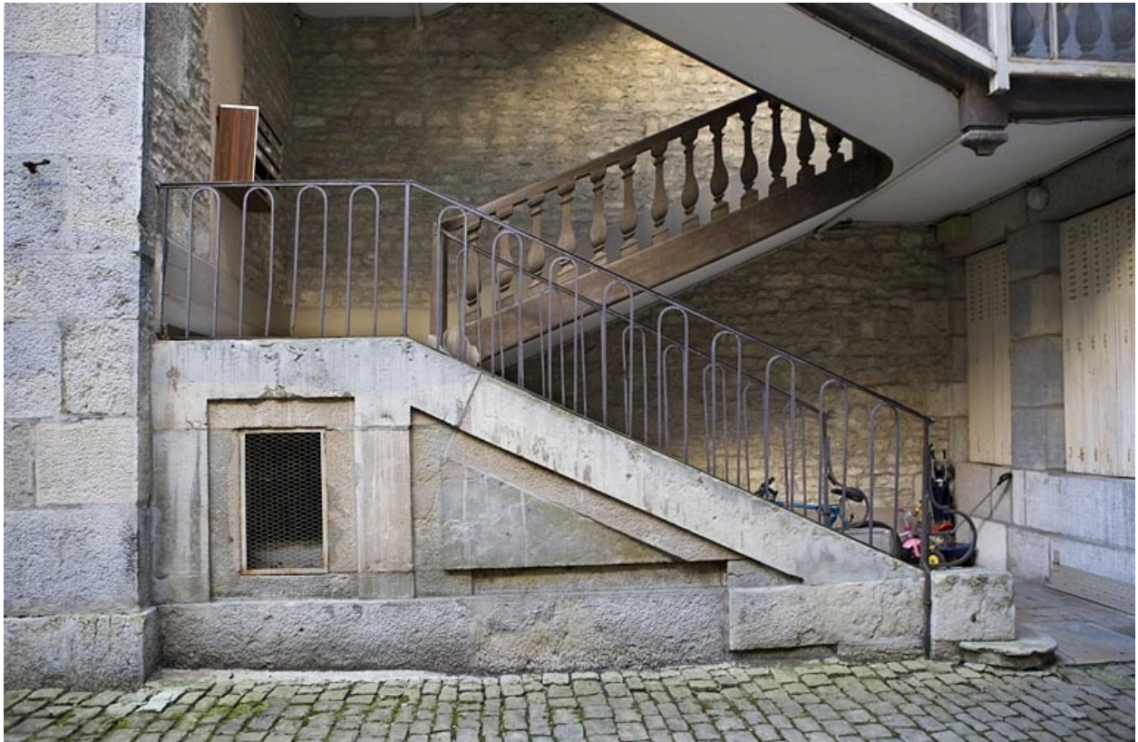
Détail du départ du premier escalier à cage ouverte depuis la cour.
