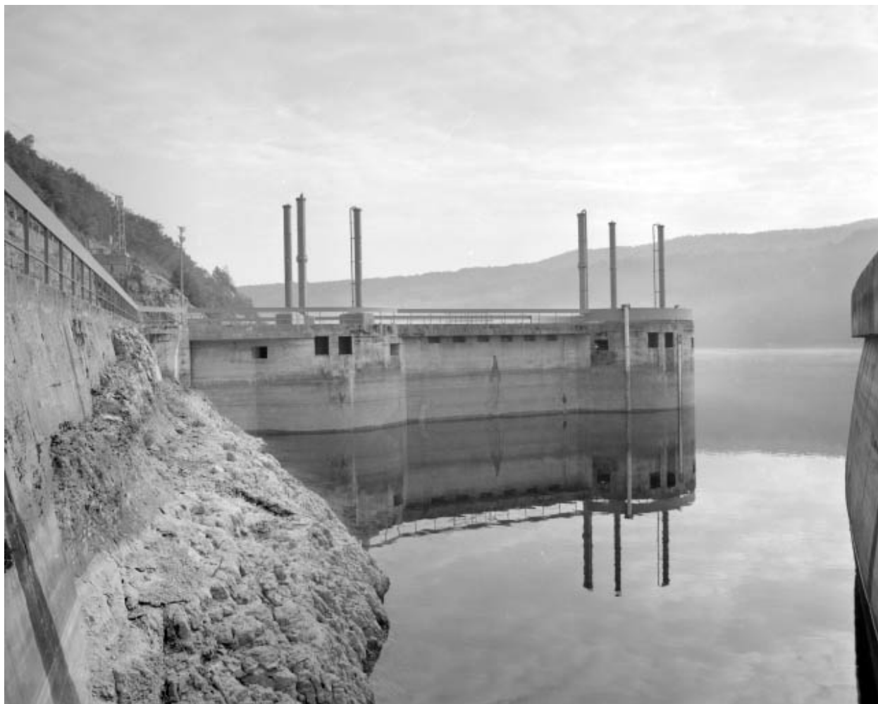
Tours de la prise d'eau.
