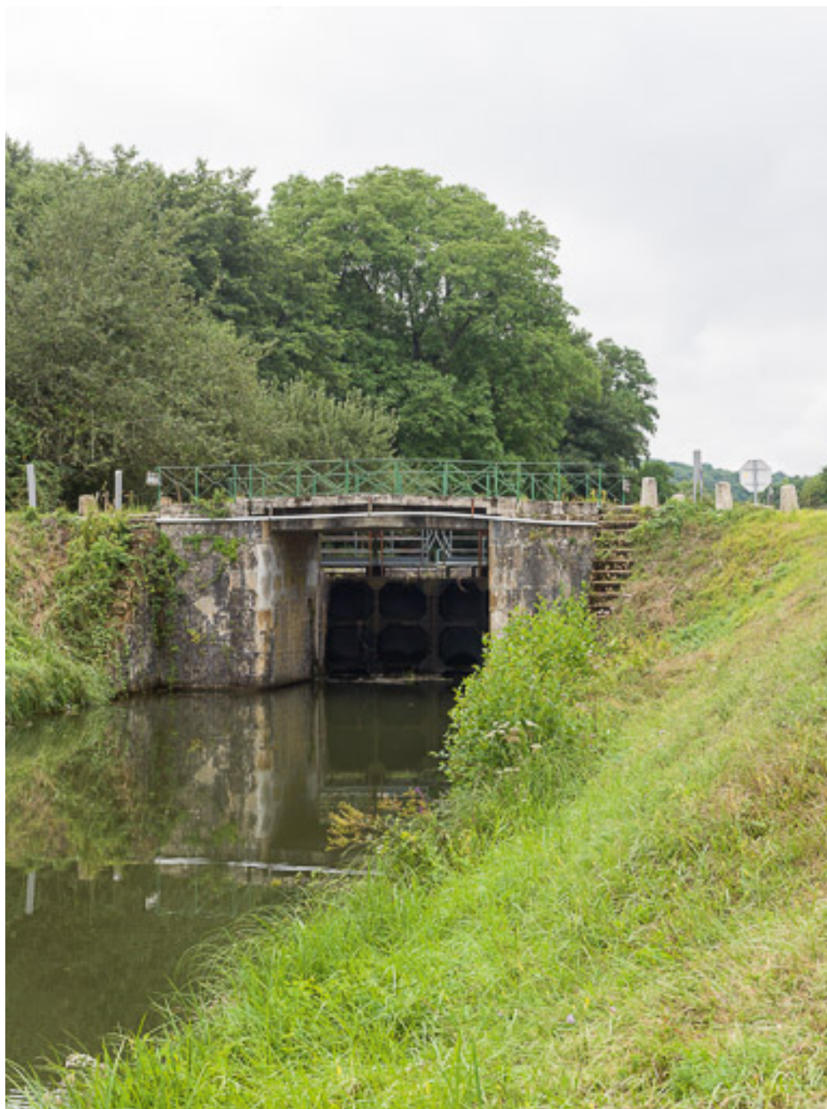
Vue d'ensemble du pont.
