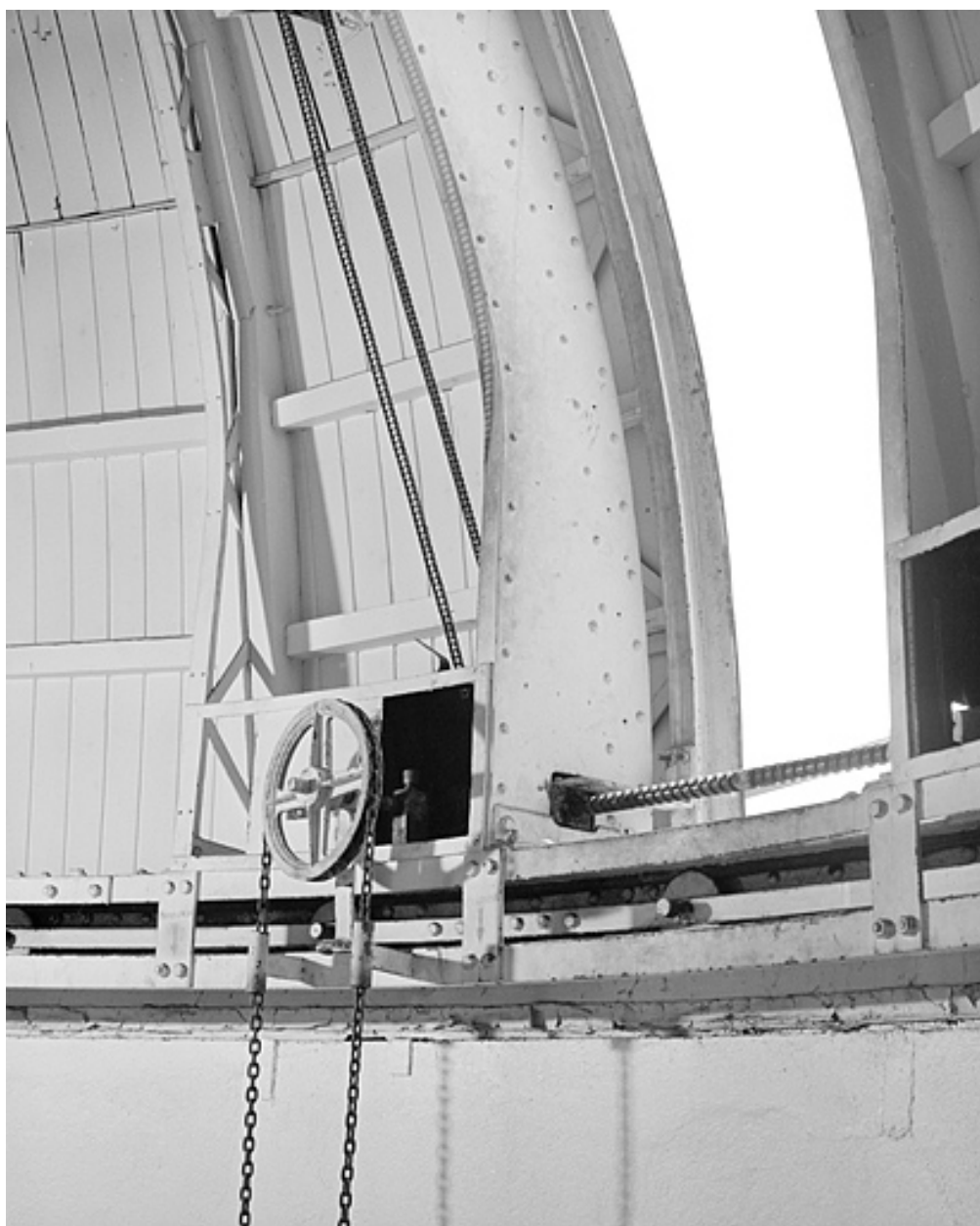
Système d'ouverture du dôme : chaîne et vis sans fin.
