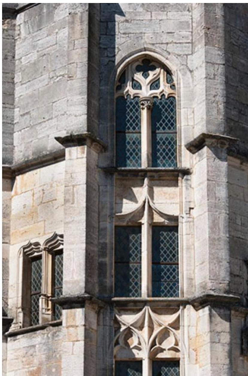
Détail des baies de la tour d'escalier
