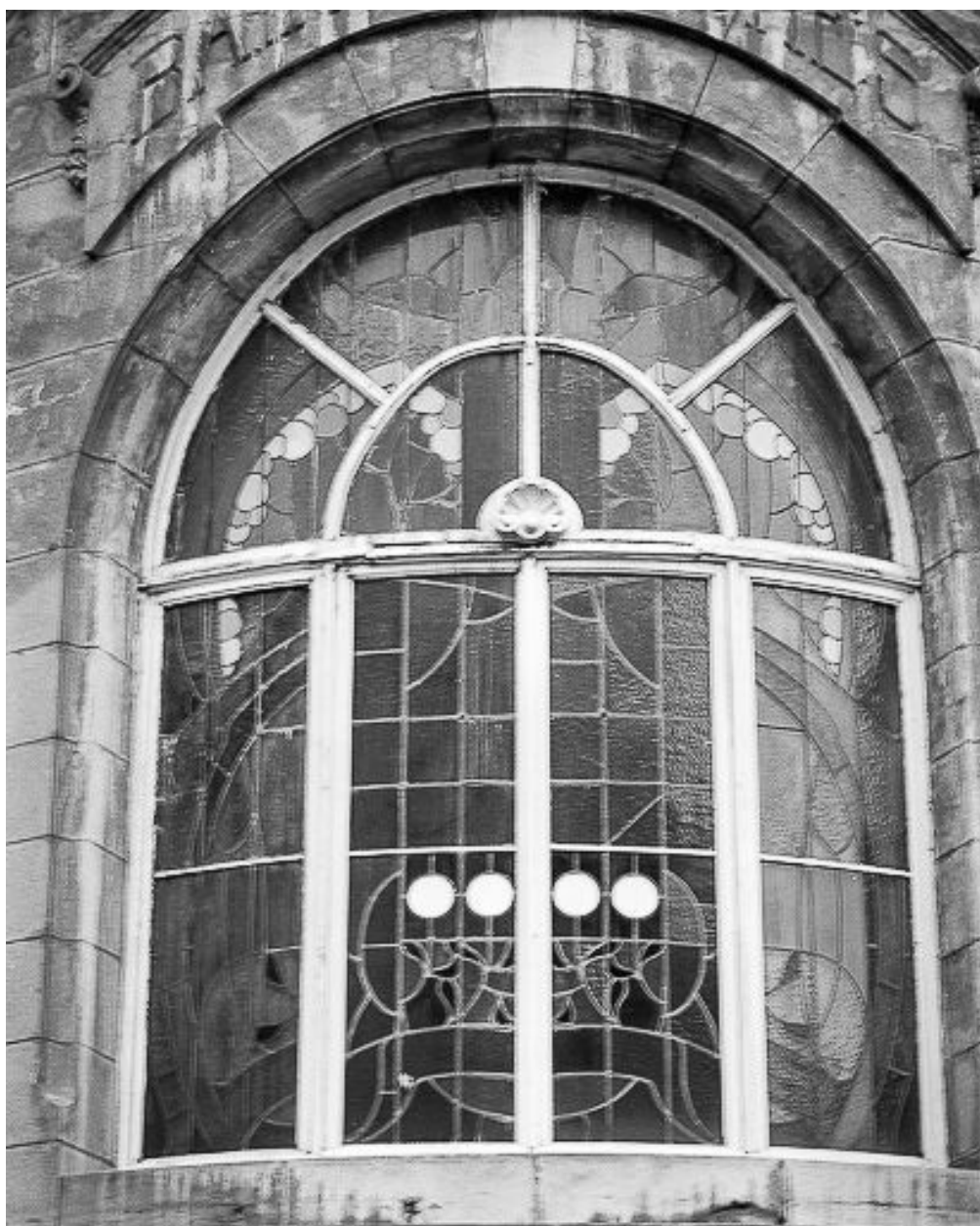
Baie cintrée vue de l'extérieur.
