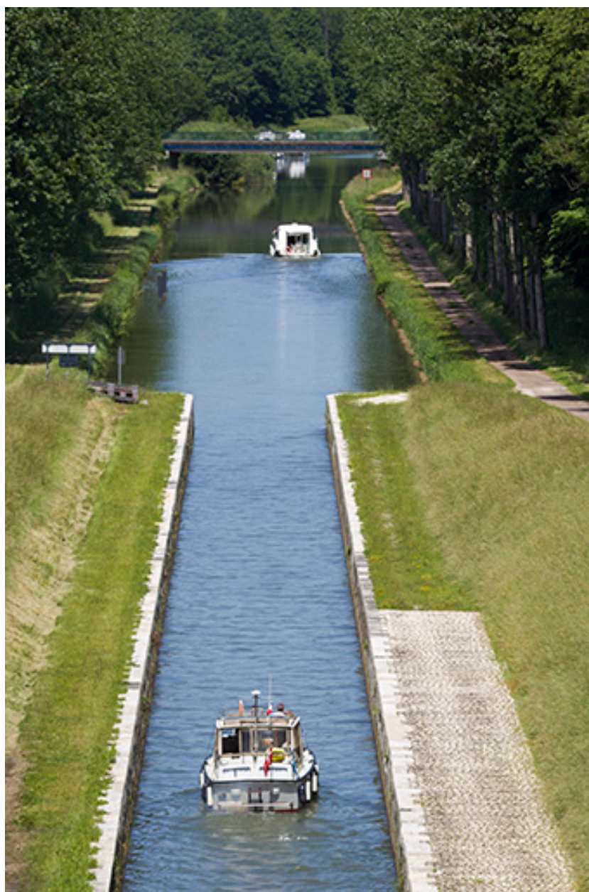
Vue amont du canal de navigation.
