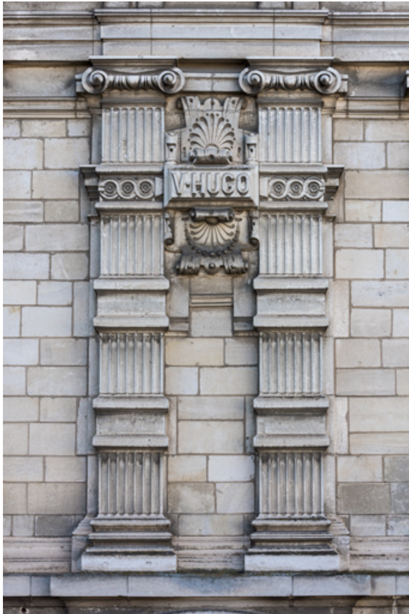
Façade latérale gauche, étage carré : pilastres et inscription V. Hugo.
