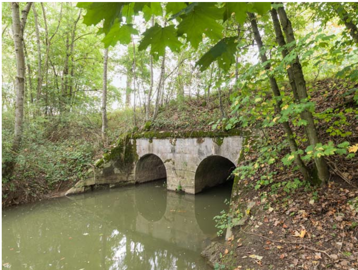
Vue de l'aqueduc.
