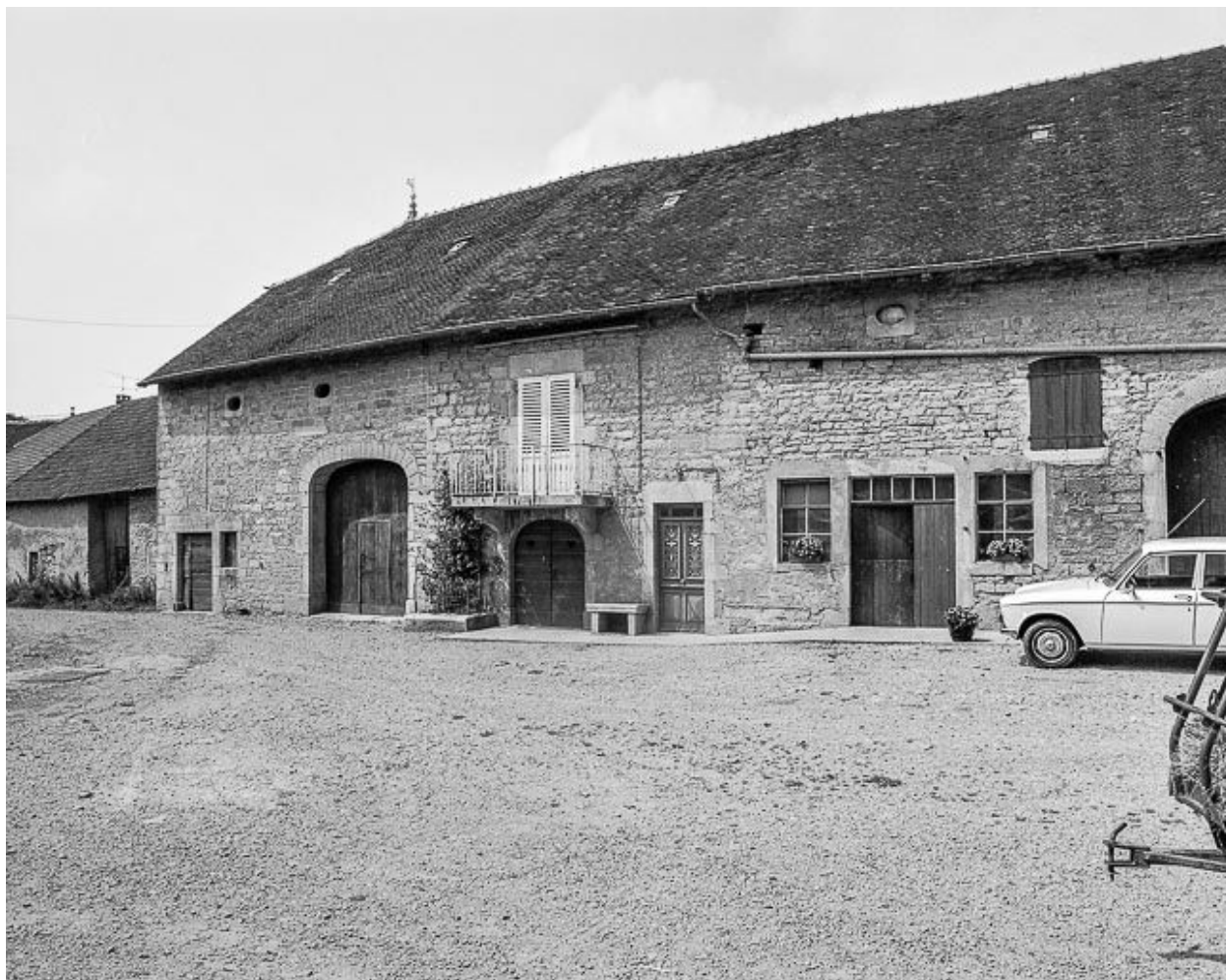
Ferme située 169 rue Saint-Néron.
