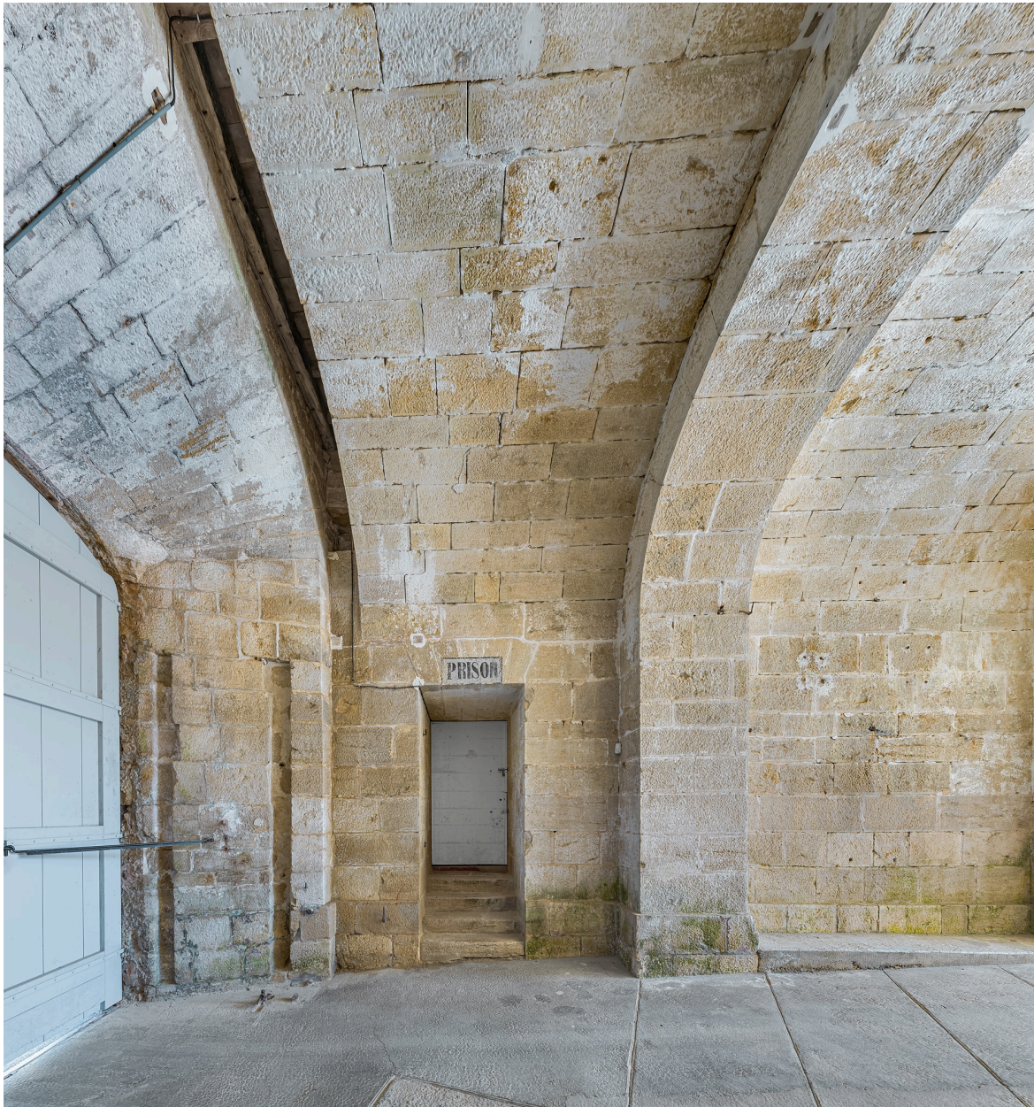
Le passage voûté : porte de l'ancienne prison.
